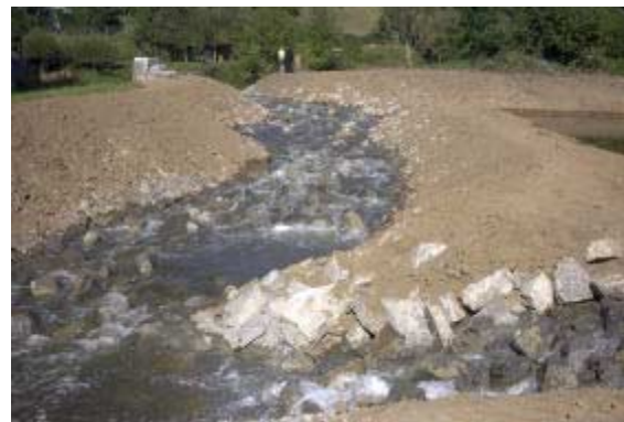
Abbildungen: Umgehungsgerinne bei Wehranlage Gochsen vor und nach dem Fluten
