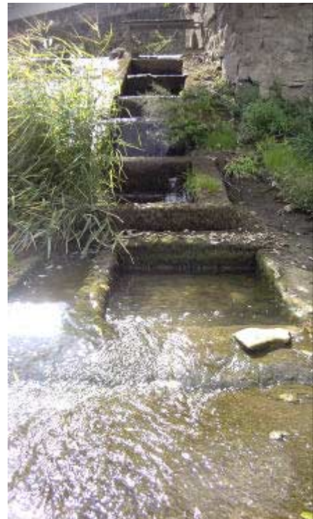
Unpassierbare Kammerfischtrappe in Forchtenberg
